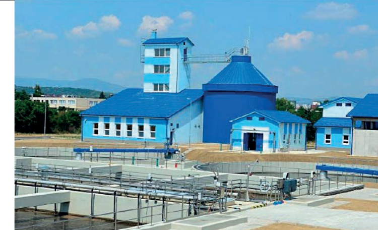
WTP, Nové Mesto nad Váhom, Słowacja
