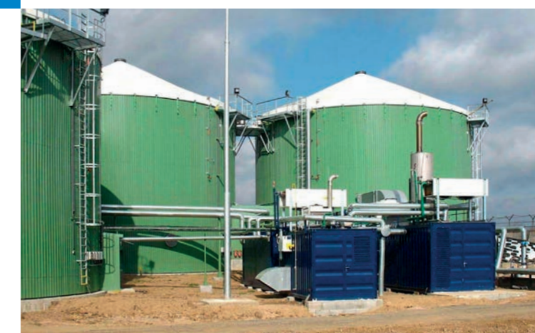
Biogazownia, Hostouň, Republika Czeska
